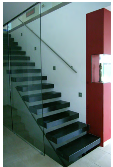
WC Trennwand Dusche | Bad Eingangsbereich eingespannte Treppenstufen
