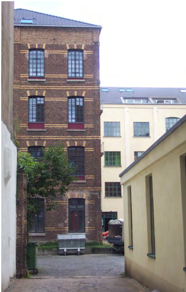
Toreinfahrt | Blick nach innen
